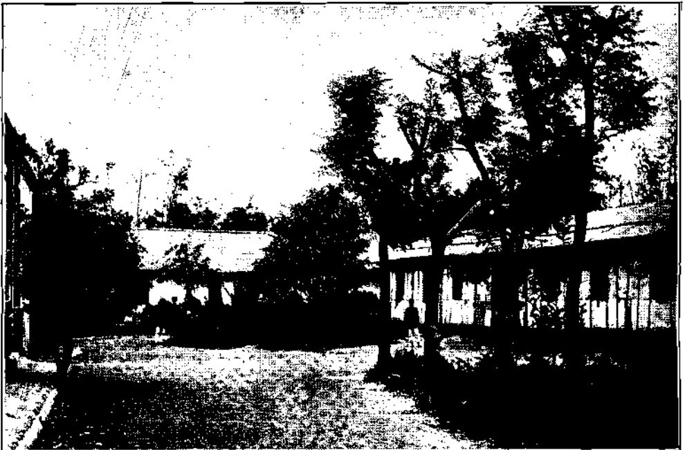
Edificio-Colegio para catequistas, en Lochunchung
